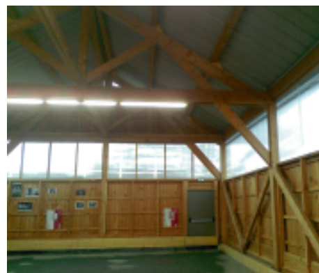
Boulodrome à Champagney (70), structure et bardage en Douglas issus de la forêt.
